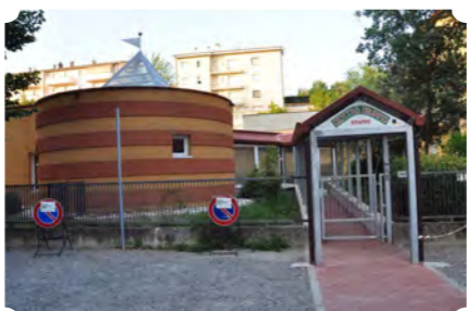
IL CENTRO DIURNO DOPO I LAVORI
