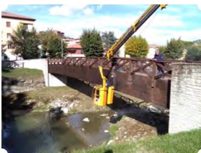
I LAVORI PRESSO IL PONTE SUL VERGATELLO
