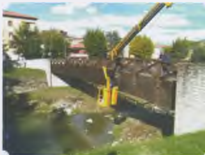
I LAVORI PRESSO IL PONTE SUL VERGATELLO
