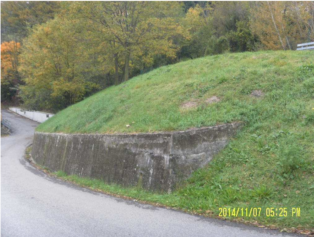
VISTA DALLA VIA BONTA' DEL MURO DI SOSTEGNO DELLA SCARPATA
