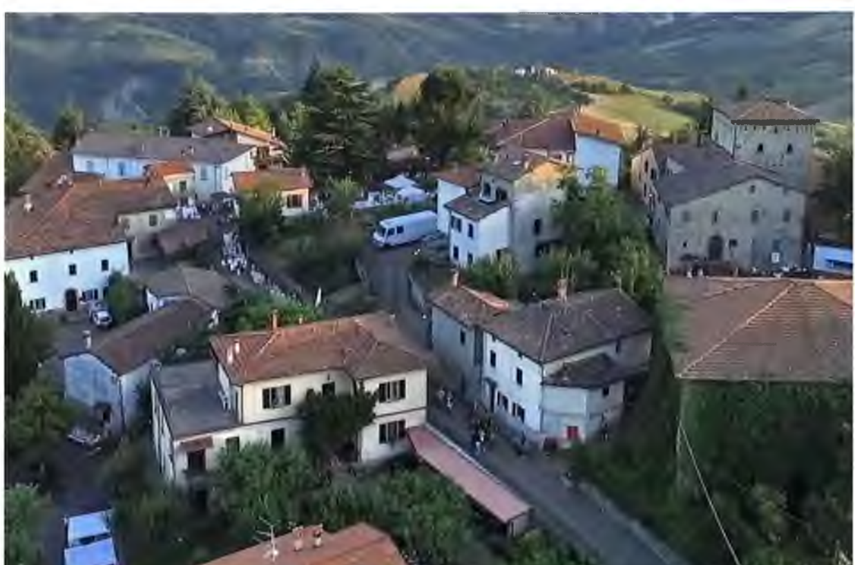
Unione Appennino Bolognese-Comune di Vergato Dissesto/Caduta Massi Loc. Tamburini
